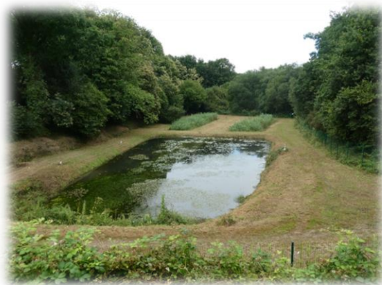
Figure 59 : Station d'épuration de Pleugriffet– Source : SMGBO
